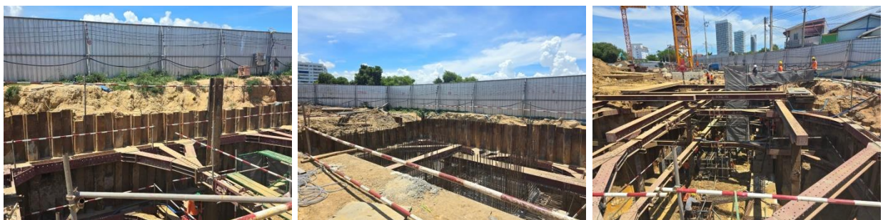
รูปที่ 2.2-5 ระบบป้องกันดินพัง แบบ Sheet Pile ร่วมกับคาน และเสาเหล็ก
